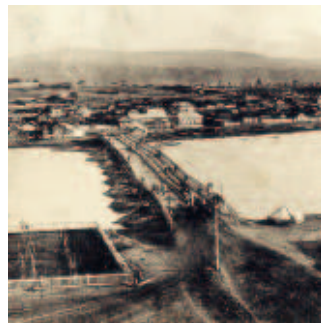
Мост через Уду
