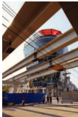
Строительство автомобильной развязки у торгового центра «Европа». 2011 г.
