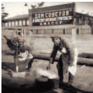
Строительство Дома Советов
